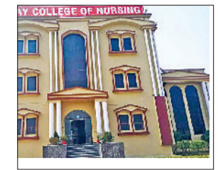
महेंद्रगढ़। उदय कॉलेज का भवन।
